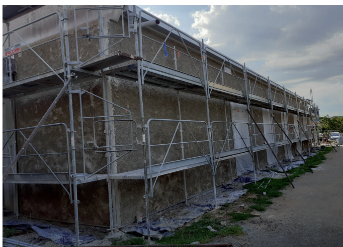
Réfection extérieure de la salle des fêtes
