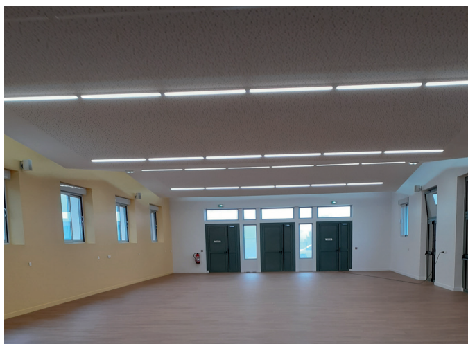
Intérieur de la salle des fêtes après rénovation
