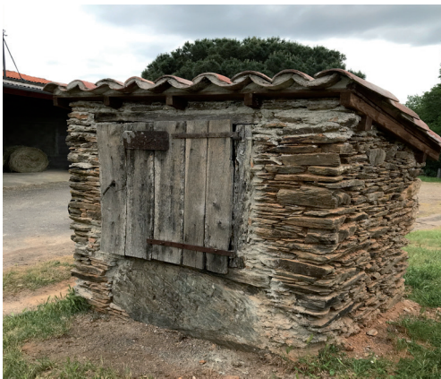
Puits restauré à Montsec
