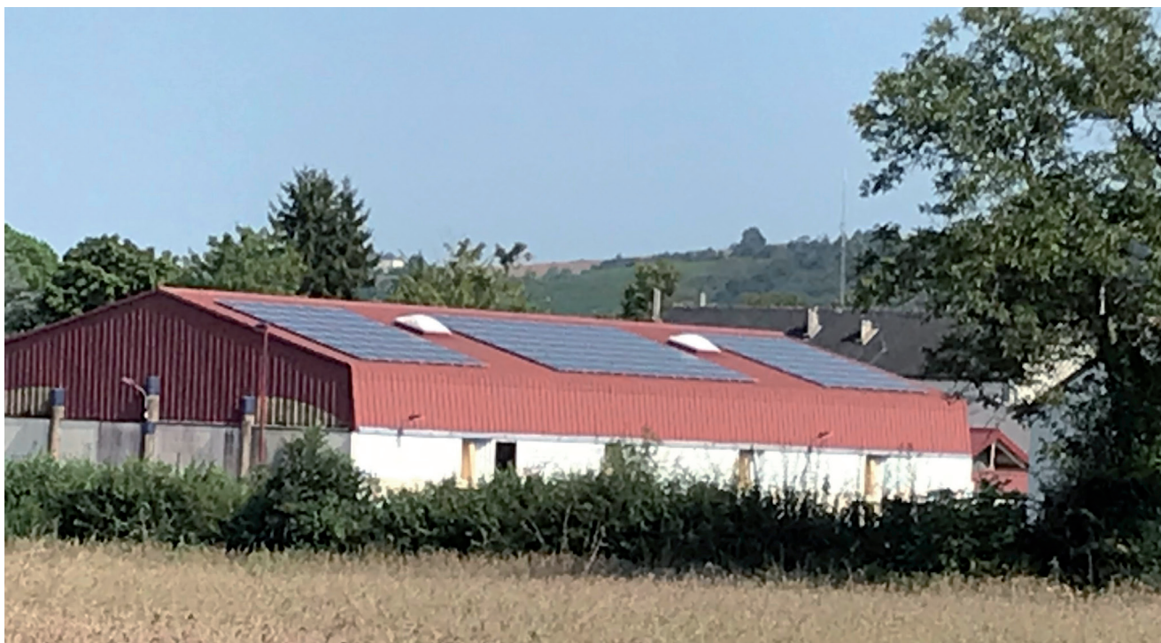
Gymnase de Pampelonne après la pose de panneaux photovoltaïques
