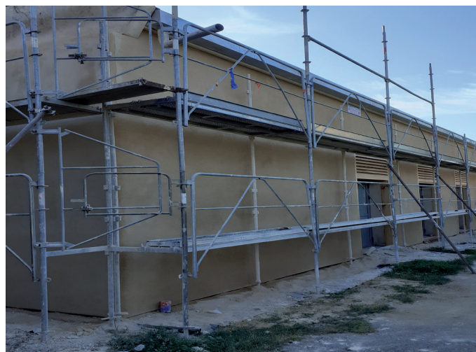
Réfection extérieure de la salle des fêtes
