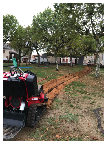
Réalisation de réseaux
