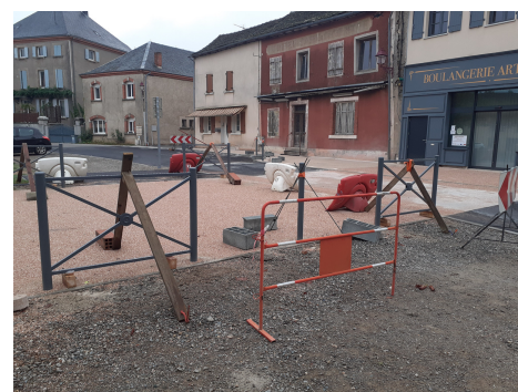
Cheminement piétons sécurisé
