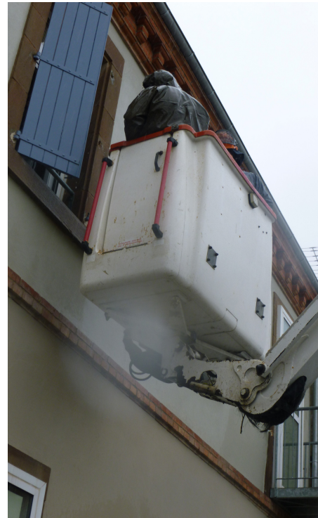
Réparation d'un volet
